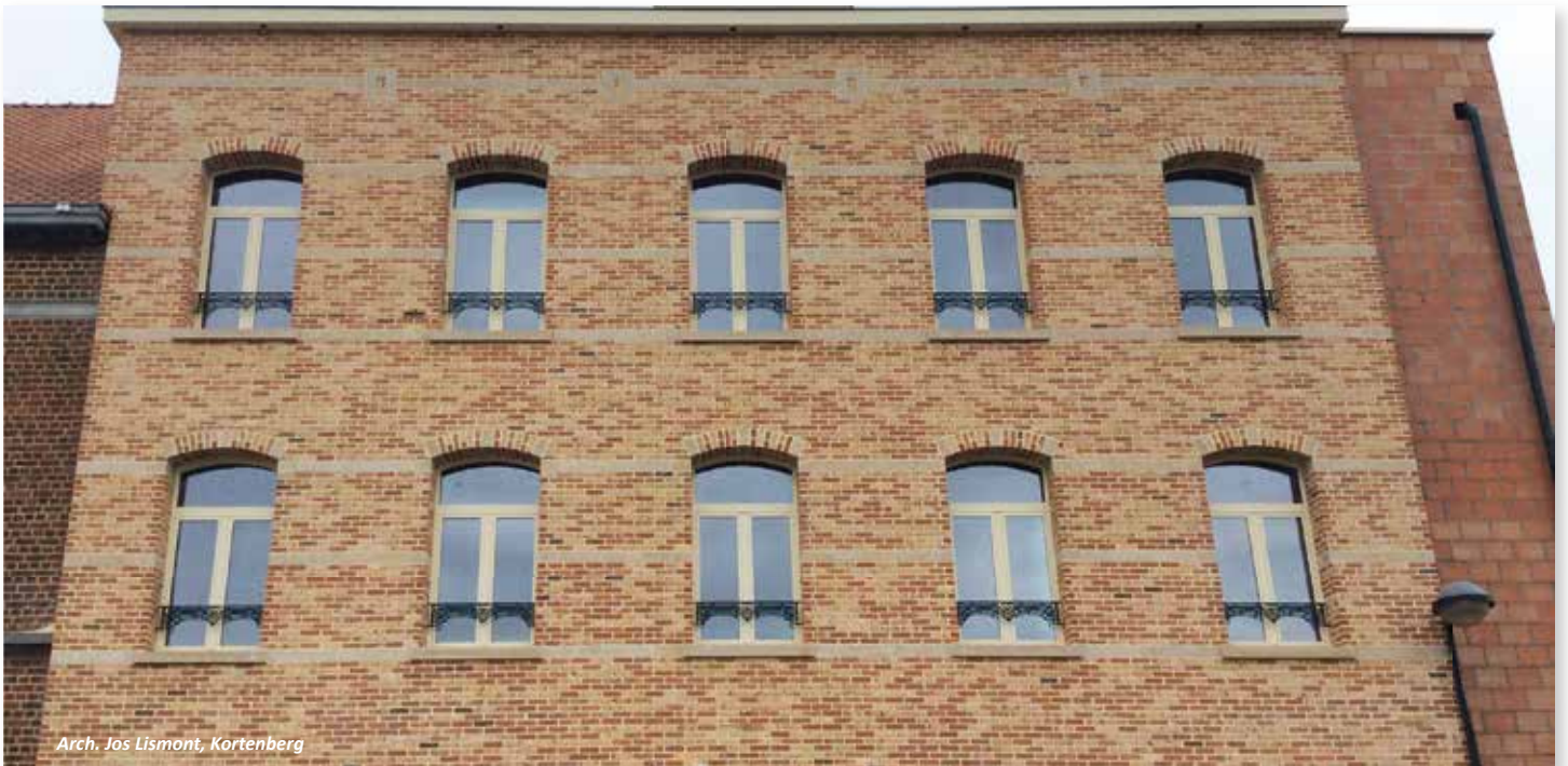
Vóór/na: upgrading en isolatie van de gevel. Steenstrippen = geen zichtbaar verschil met traditionele volle gevelstenen.
