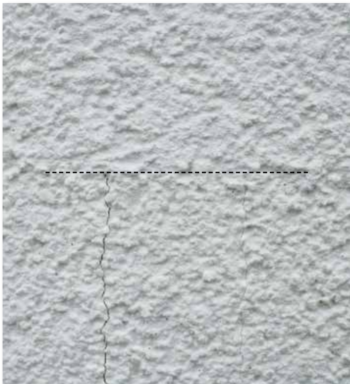
Boven de lijn opgevuld met WILLCO Filler.
