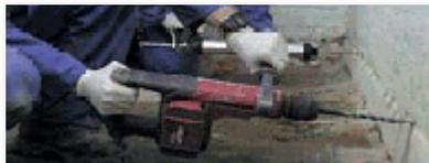
Pas de forages multiples, pas de temps d'attente jusqu'à saturation pendant l'injection – forage et injection en une seule opération.
