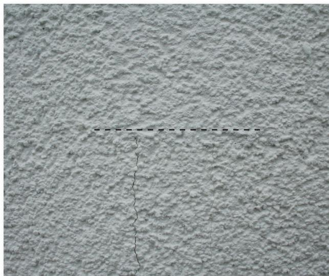
Au-dessus de la ligne, les fissures sont remplies avec WILLCO Filler
