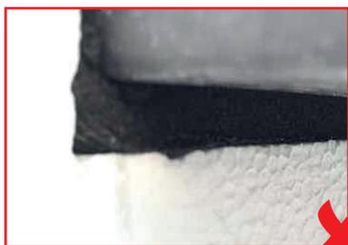
*Bande de jointoiment étanche de 15/2-6 mm mise en œuvre avec débordement trop important = pas étanche à la pluie battante !*
