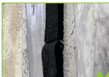
*Bande de jointoiment étanche de 15/3-9 mm mise en œuvre (bout à bout).*
