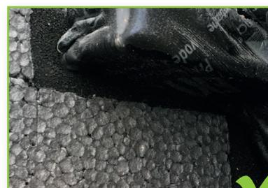
*Bande de jointoiment étanche de 30/13-24 mm mise en œuvre.*
