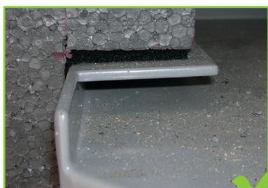
*Bande de jointoiment étanche de 15/2-6 mm mise en œuvre.*
