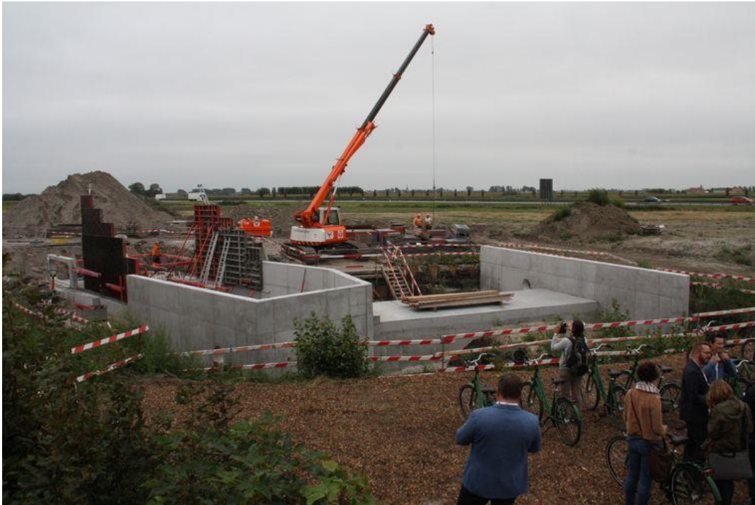
GUS De constructie weegt 1.000 ton.
