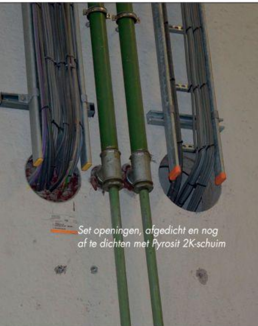
Afgewerkte doorvoer met Pyroplug
